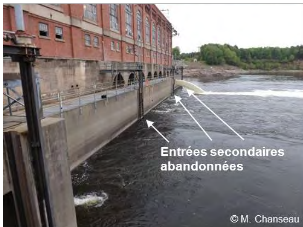
ÉTATS-UNIS 10 : CONNECTICUT – VERNON : (de haut en bas et de gauche à droite) : vue aérienne de l'ouvrage de Vernon sur la rivière Connecticut ; vue aval de l'usine ; vue de l'entrée de la passe ; vue des entrées secondaires condamnées ; vue de la passe à bassins (Ice Harbor).
