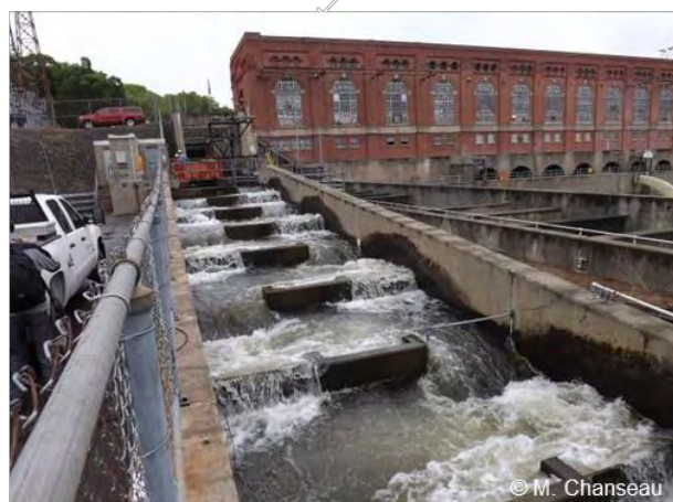
ÉTATS-UNIS 10 : CONNECTICUT – VERNON : (de haut en bas et de gauche à droite) : vue aérienne de l'ouvrage de Vernon sur la rivière Connecticut ; vue aval de l'usine ; vue de l'entrée de la passe ; vue des entrées secondaires condamnées ; vue de la passe à bassins (Ice Harbor).
