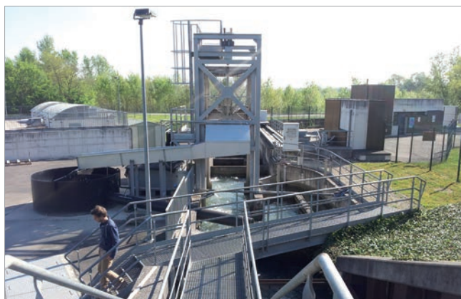
Station de comptage de la passe à poisson du barrage de Gamsheim, second obstacle à la migration anadrome dans le Rhin
