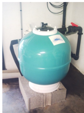
Figure 7 : Le filtre à sable et son principe de fonctionnement
