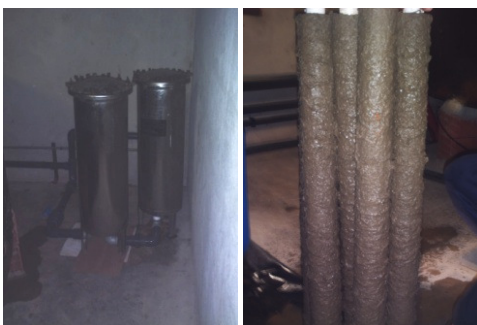
Photographie 8 : A gauche, les filtres à cartouche en fonctionnement, à droite les cartouches usagées
